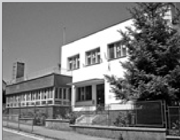
V červenci zahájila pardubická Labská stavební společnost práce na rekonstrukci Mateřské školy v ulici Za Fontánou. Pět měsíců budou děti docházet do provizorně vybavených tříd v budově bývalého Domu pionýrů. Do své školky se vrátí už v prosinci letošního roku.
