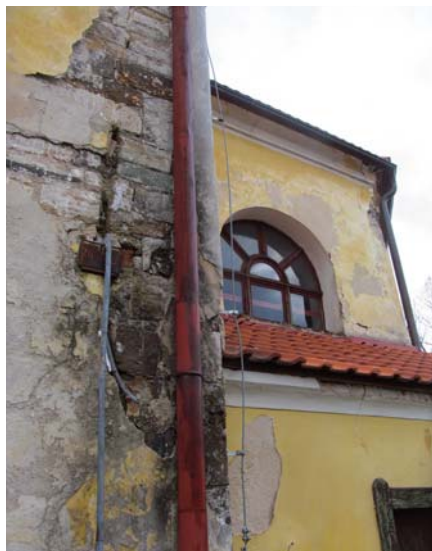
Pohled na závěr kostela sv. Petra a Pavla zachycuje jeho stavební vývoj – pod opadanou omítkou lze spatřit kvádříky románského zdiva, polygonální presbytář odkazuje k časům gotiky, ale velké okno je již novověké. Nechybí ani industriální doplňky naší současnosti – jakási elektroinstalace, okap a hromosvod.
